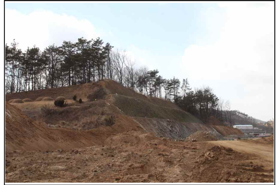
【그림 4】 깎기비탈면 종점부 측면 사진
