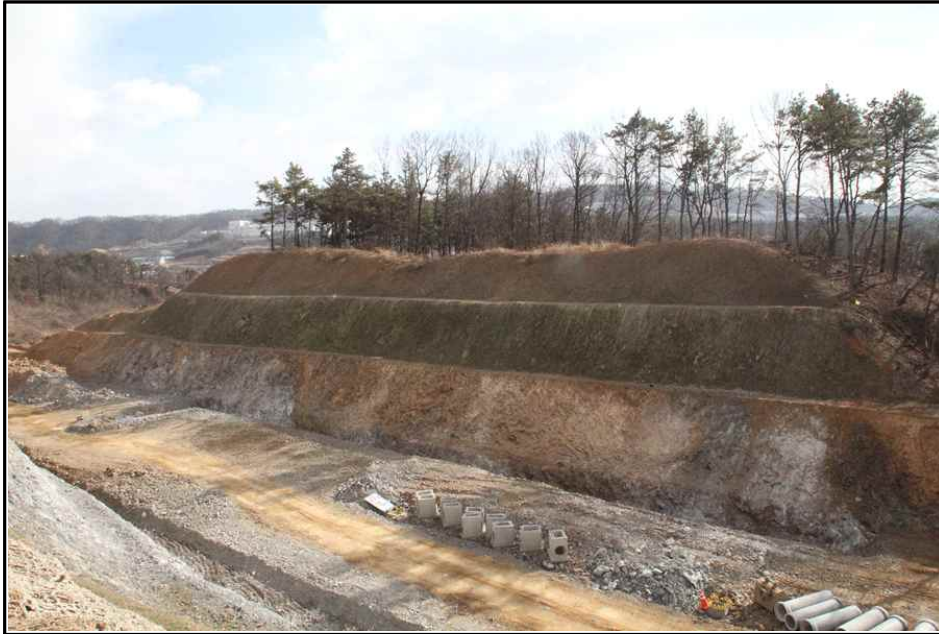
【그림 3】 깎기비탈면 시점부 측면 사진
